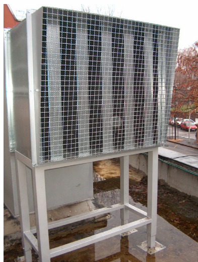
Exemple de réalisation AD Ingénierie
